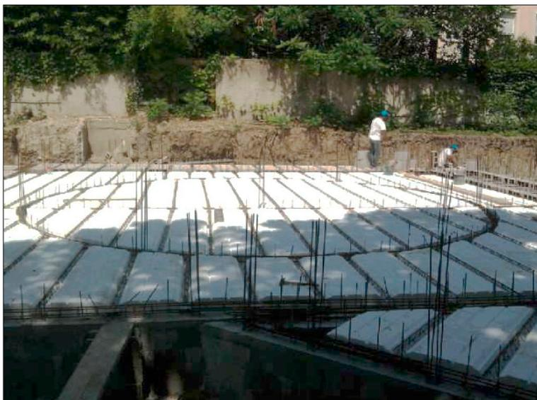
*Fig. 9 Pose des premiers éléments de la dalle*
