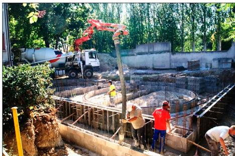
Fig. 8. Coulage du béton du soubassement.
